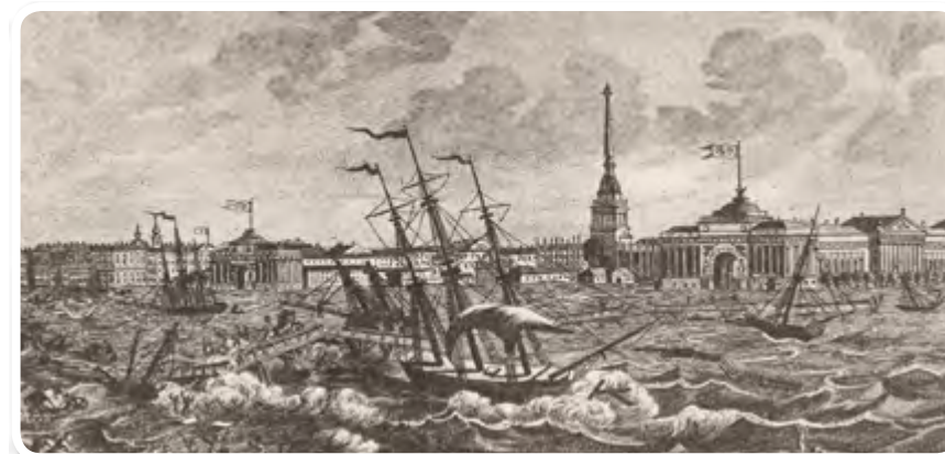
Наводнение в Санкт-Петербурге
